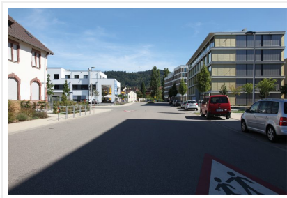
Güterbahnhofareal Freiburg: Straßenbreite circa 12,5 Meter + PKW Parkstreifen und Fußgängerweg – bislang ohne Ausbildung eines Fahrradwegs
