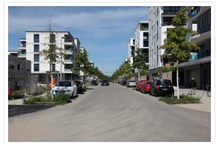
Gterbahnhofareal Freiburg, Verteilerstrasse mit PKW Parkstreifen, Fugngerweg + Gebudevorzone. Fahrwegbreite circa 6,5 Meter, kein Fahrradweg gekennzeichnet, Fotos: Hannelore Pfeifer
